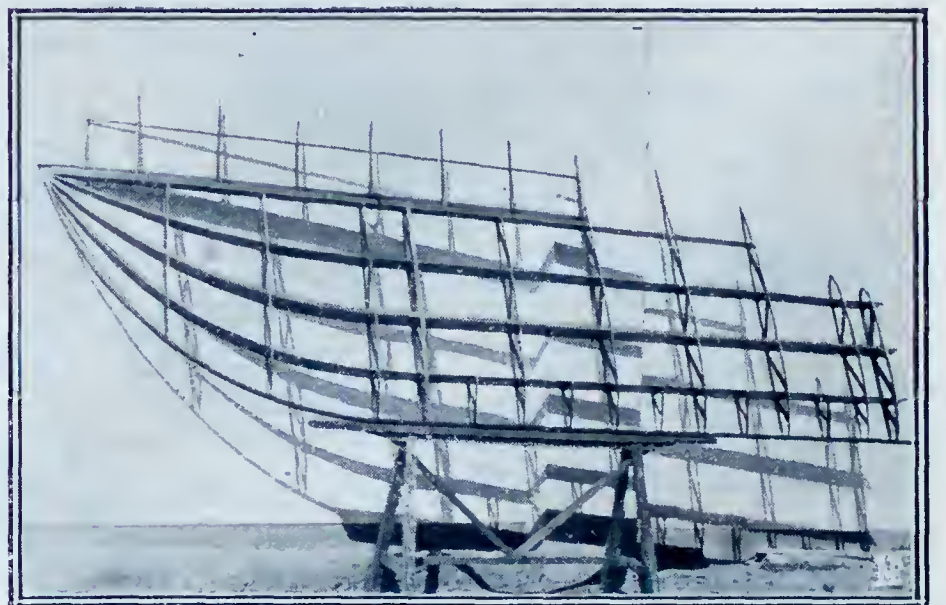
Scheletro in legno dell'ala maestra destra (Per copertura in fogli di legno compensato)
